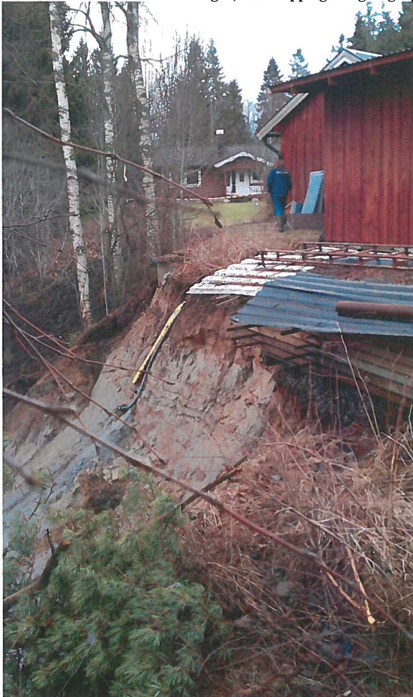
Bild 2 Skredkant med belastningar, virkesupplag och garagebyggnad
