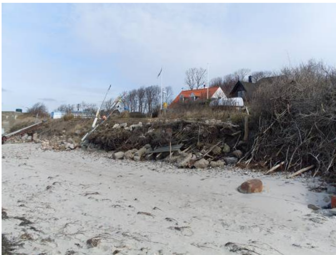
Bild 5-1. Erosionsbranter och erosionsskydd vid Fortuna. (Foto: Bengt Rydell, SGI)
