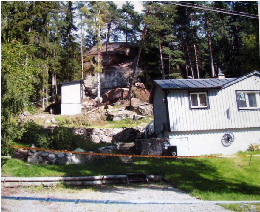
Bild 2.7. Ras i bergslänt vid Skriketorp, Norrköping. Foto: SGI.
