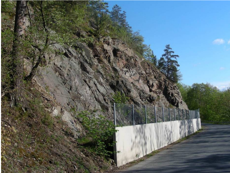
Bild 2.10. Sprängd bergslänt i sprickrik gabbro vid Vista kulle. Stabilitet i den naturliga bergslänten har blivit försämrad genom sprängningen i bergslänten. Foto: SGU.
