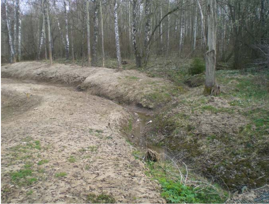
Bild 3.9. Avskärande dike nedanför höjdområdet ovanför IKEA. Diket är grävt genom äldre utspolade massor av lätterederad finjord. Delområde O:505. Foto: SGI.
