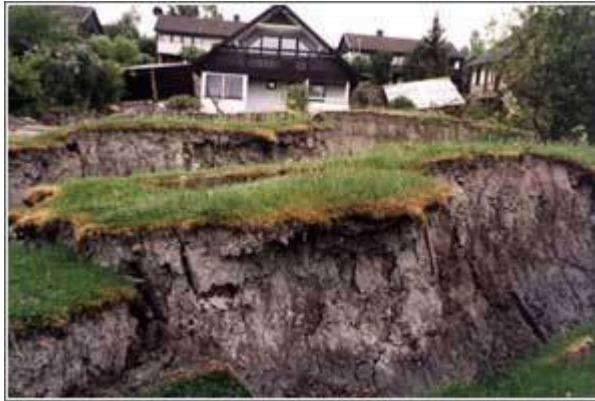
Bild 2.5. Skred i lera i Vagnhärad 1997, Södermanland. Foto: SGI.
