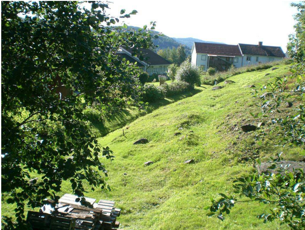
Bild 14. Troligen den äldre bäckfåran mot bebyggelse. Om trumman sätts igen under gatan, som finns till vänster bakom trädet, kan bäcken söka sig längs denna gamla bäckfåra med risk för bostadsbebyggelsen i bakgrunden.
