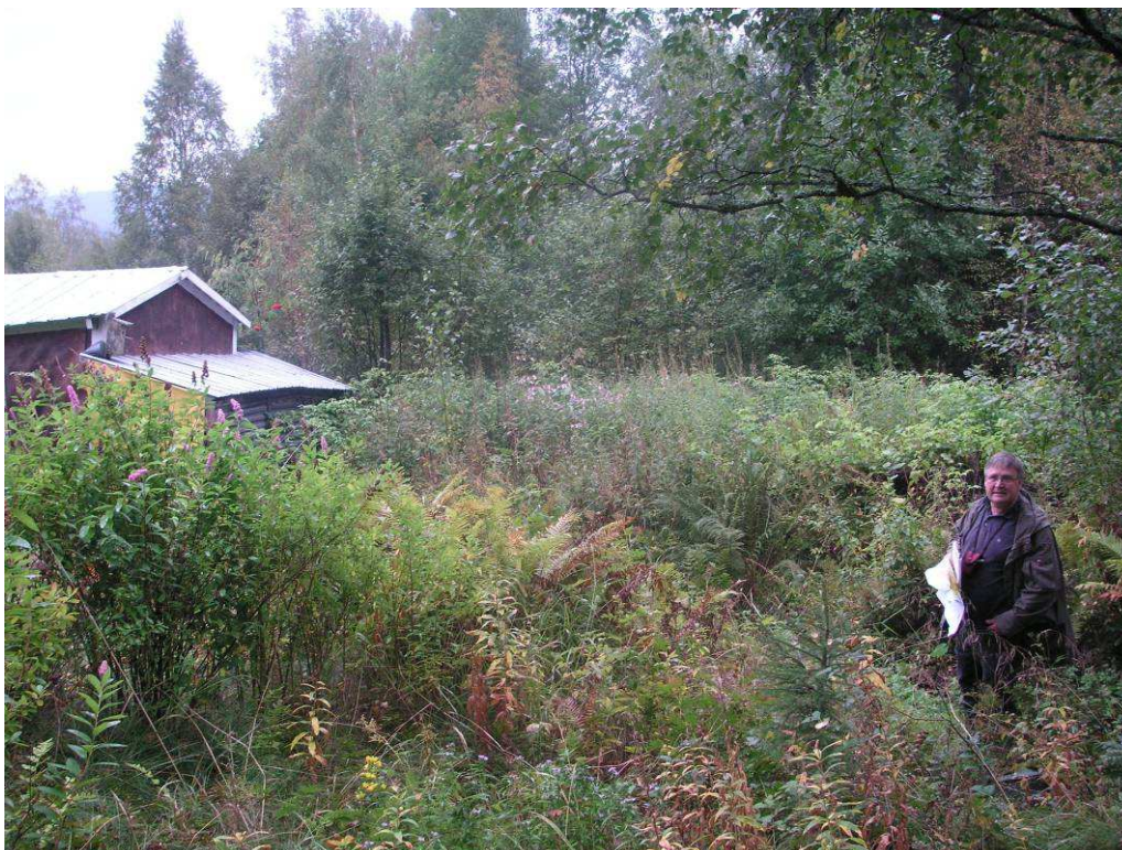
Bild 5. Bebyggelse i närheten av mindre bäck, som delvis rinner i ett grävt dike. Diket leds bl.a. in under uthuset på bilden, vilket medför dämningrisk och att uthuset kan skadas vid höga flöden.
