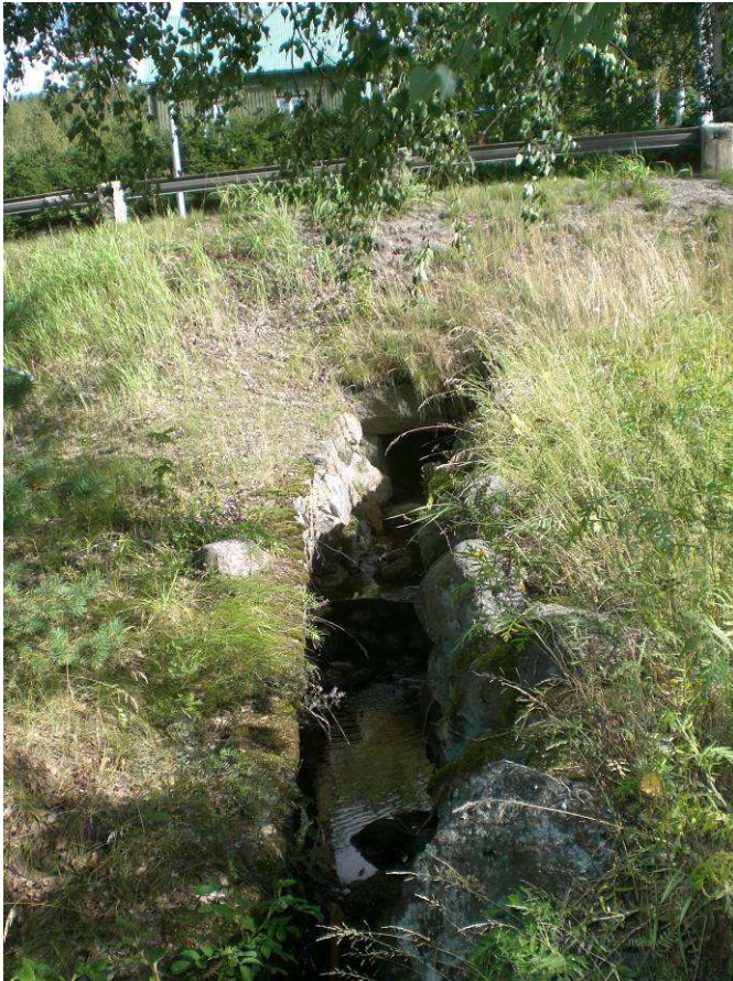
Bild 1. Bäck som rinner genom villabyggelse och passerar genom en trumma under en större landsväg (gamla E4). Bilden visar utloppet från trumman.
