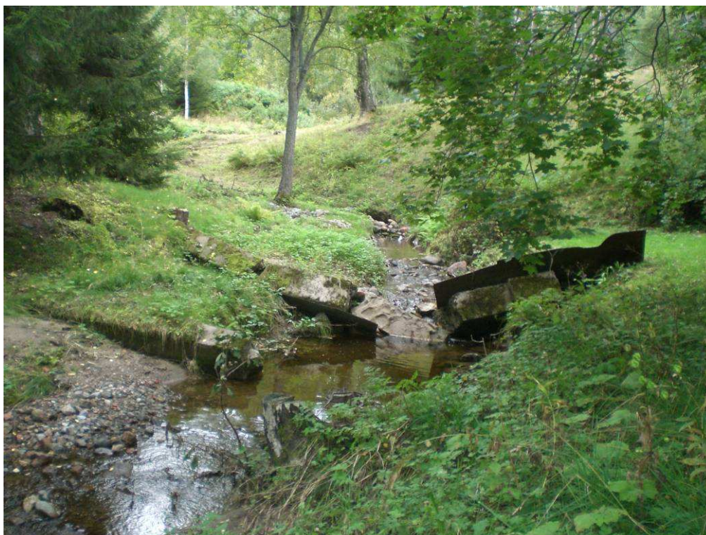
Bild 4. Bäck fotograferad i västlig riktning. Erosion, levéer och "hemmabyggd" erosionstrappa (kontrolldamm) nedanför bebyggelse
