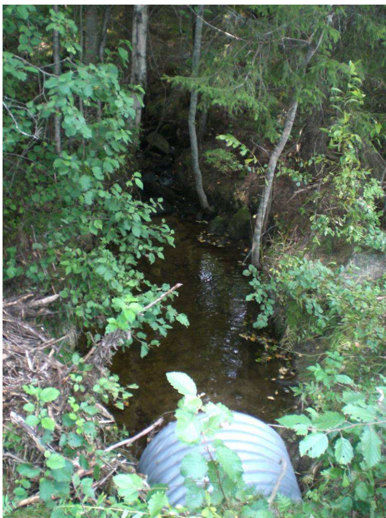
Bild 10. Fotografi mot öster där en skogsväg korsar bäcken med en vägtrumma. Spår av erosion över vägen på grund av att vägtrumman ibland sätts igen, så att vatten rinner över vägen.
