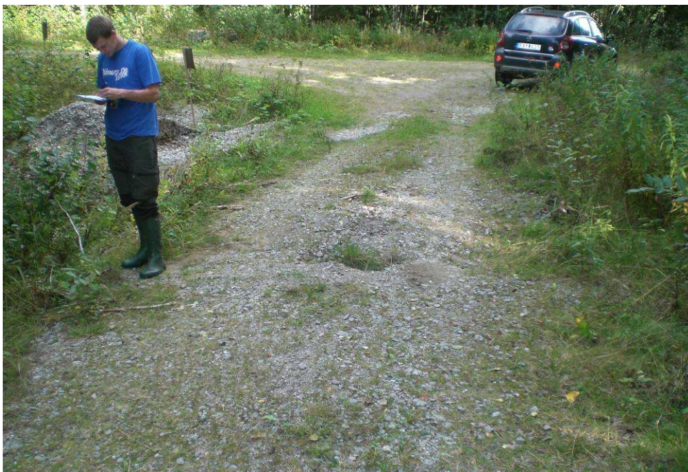
Bild 10. Fotografi mot öster där en skogsväg korsar bäcken med en vägtrumma. Spår av erosion över vägen på grund av att vägtrumman ibland sätts igen, så att vatten rinner över vägen.
