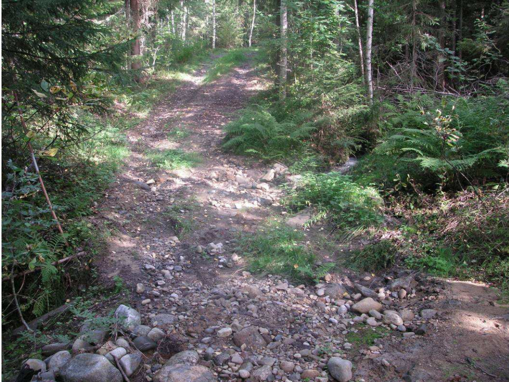
Bild 3. Bäckan går med en trumma under en mindre skogsväg. Bäckan rinner tidvis över och eroderar vägen trots trumman.
