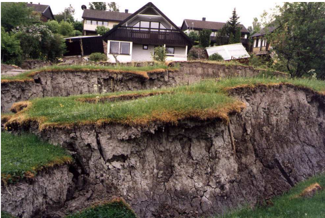
Figur 8-2. Skred i Vagnhärad, 1997. Foto: SGI.
