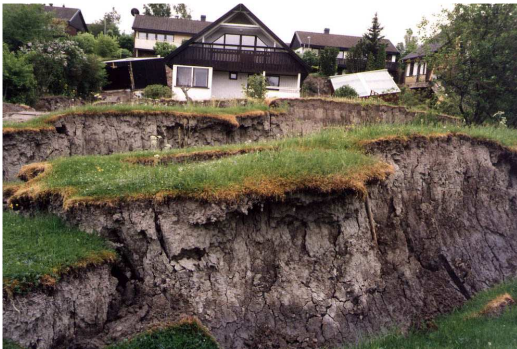
Figur 8-2. Skred i Vagnhärad 1997. Foto: SGI.
