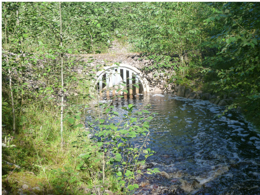
Karteringspunkt nr 16. Närbild på trumma med galler uppströms vägen.
