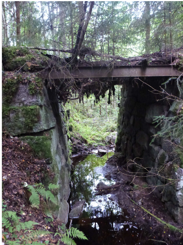
Karteringspunkt nr 20. Gammal trasig kallmurad bro. Avstånd till vattenytan ca 4 m från underkanten på bron. Blocksamling i botten av bäcken, troligen från den trasiga bron.
