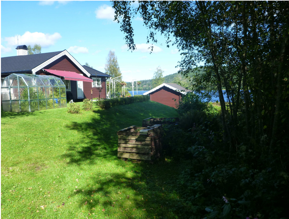
Karteringspunkt nr 14. Hus nära släntrön på södra sidan av bäcken.
