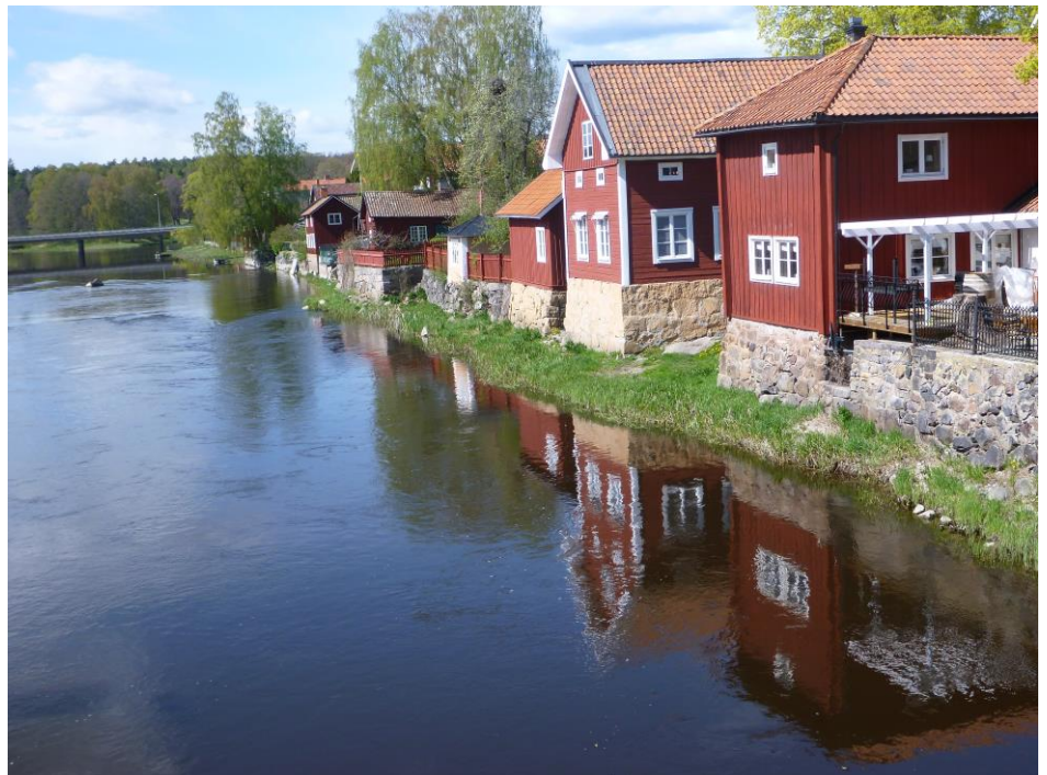
Erosion vid äldre bebyggelse utmed Arbogaån i Arboga, Västmanlands län.
